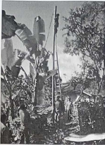
Pemasangan kabel jaringan
