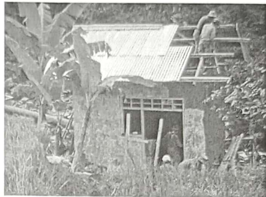
Pembangunan power house
