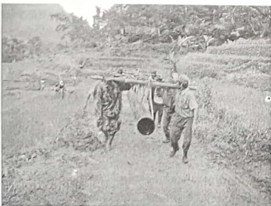
Pengangkutan pipa penstock
