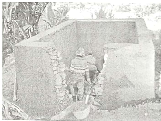
Pembuatan bak penampungan
