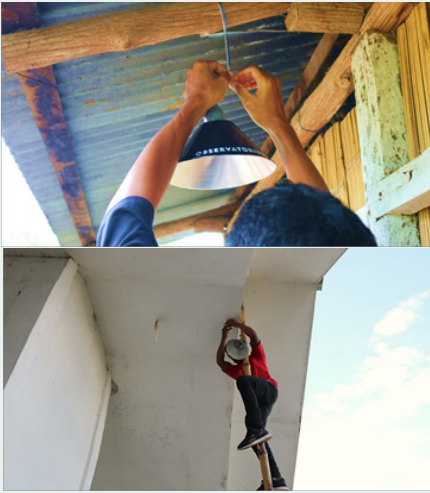
Gambar 2. Proses Pemasangan Tudung Lampu
