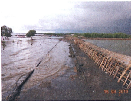
Gambar 11. Tanggul Tambak yang Dibuat dari Bamboo 39
