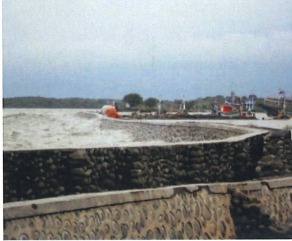
Gambar 14. Tanggul Dibangun dengan Batu kali 43
