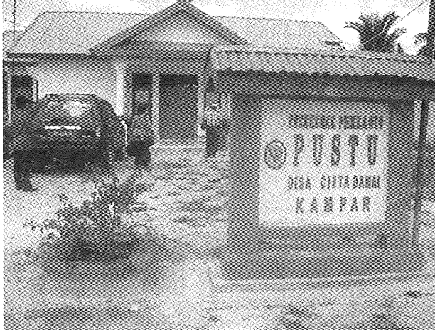
Puskesmas Pembantu (Pustu) Desa Cinta Damai, Kabupaten Kampar yang dibangun oleh Pengusaha LBD.
