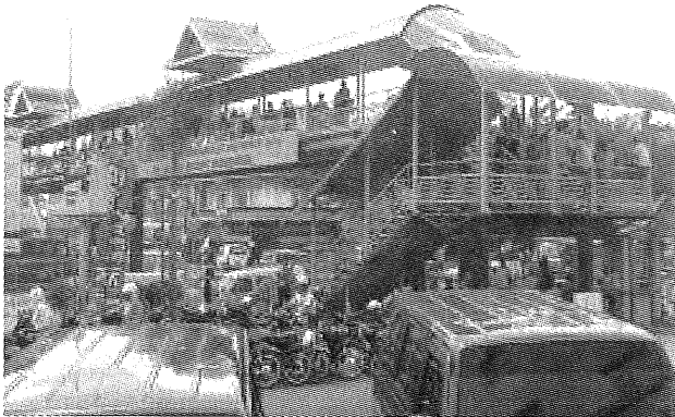
Satu dari tiga Jembatan Penyeberangan yang dibangun menggunakan jasa Politeknik Caltex Riau (PCR).
