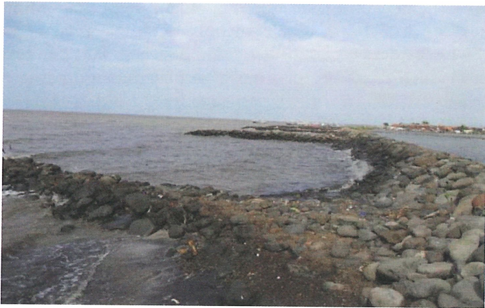
Foto 2. Perlindungan Dinding Pantai dari Ancaman Abrasi dengan Kontruksi Batu Kali Disemen.
