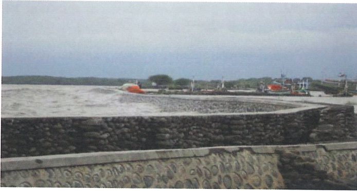
Foto 2. Perlindungan Dinding Pantai dari Ancaman Abrasi dengan Kontruksi Batu Kali Disemen.
