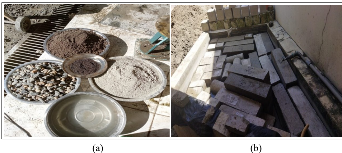
Gambar 4. Proses pembuatan benda uji dan proses curing.
