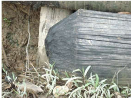
Gambar 3. Tiang kayu utuh yang dibentuk lancip untuk bagian yang menancap di tanah.
