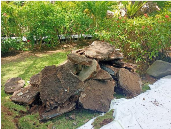
Gambar 1. Pekerjaan Buangan Tanah dan Material Ke Luar Lokasi Sumber : Nilawati, 2021
