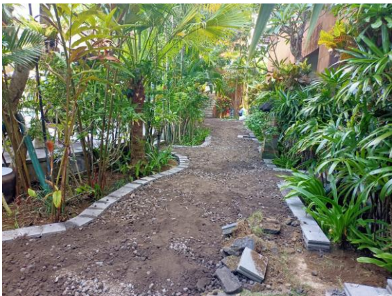
Gambar 2. Area Pekerjaan Batu Andesit Sumber : Nilawati, 2021
