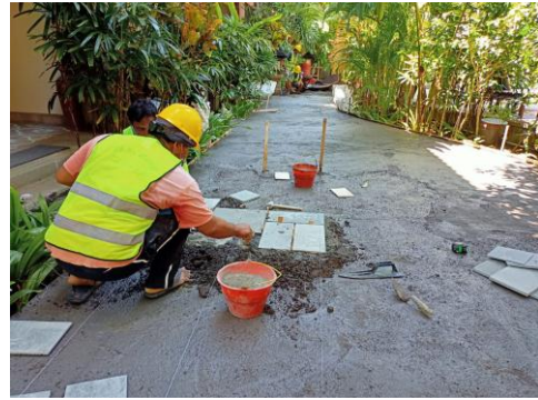
Gambar 4. Pekerjaan Beton Rabat Lantai Pathway Sumber : Nilawati, 2021
