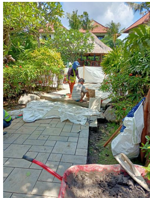
Gambar 5. Pekerjaan Pemasangan Batu Andesit Sumber : Nilawati, 2021
