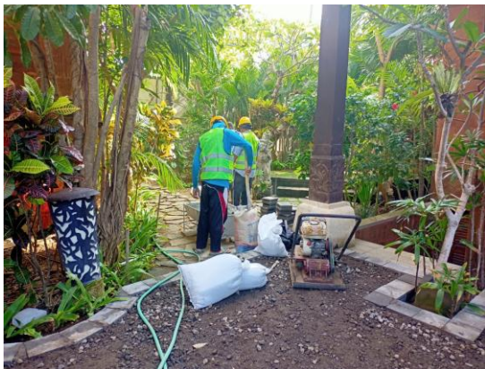
Gambar 3. Persiapan Plat Lantai Kerja Sumber : Nilawati, 2021
