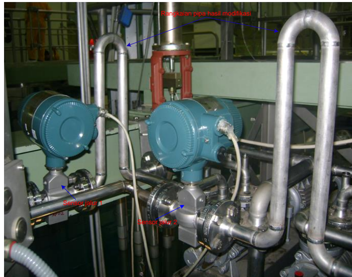
Gambar 3. Instalasi pipa pendingin sekunder pasca modifikasi
