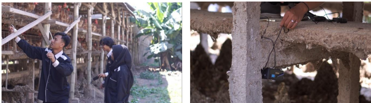
Gambar 4. Proses Pemasangan Alat IoT
