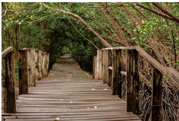
Foto 1. “Jembatan Lawas”, 2022 (Sumber: Hendri Febriyanto)
