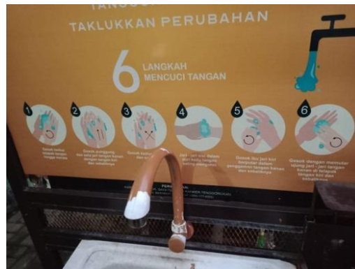
Gambar 3. Pemasangan Tempat Cuci Tangan
