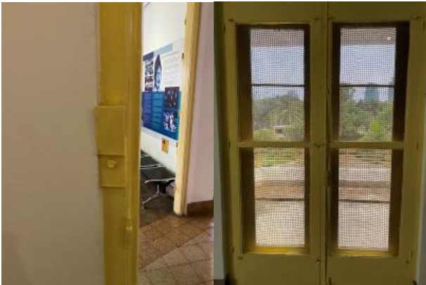
Gambar 14. Pengunci ruangan (kiri) dan pintu yang dilapisi kasa dari kawat pada kamar pribadi Maeda (kanan).
