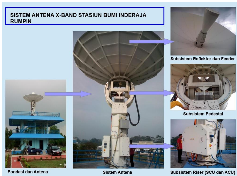
Gambar 4. Sistem eksisting antena XBand 5.4m Viasat
