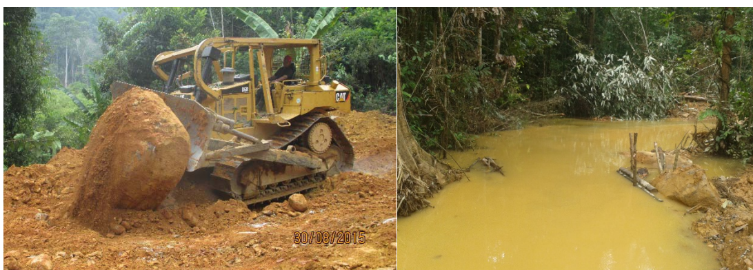
Gambar 8. Pembuatan bendungan pengalih
