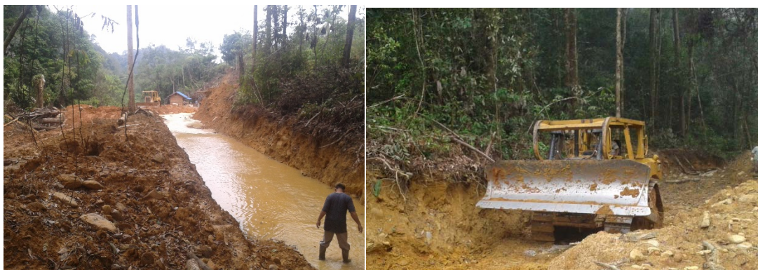
Gambar 9. Pembuatan saluran pembawa
