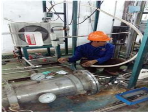
Penyambungan mesin refrigerator
