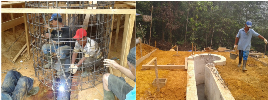
Gambar 12. Pembuatan saluran turbin yang bentuknya seperti rumah siput
