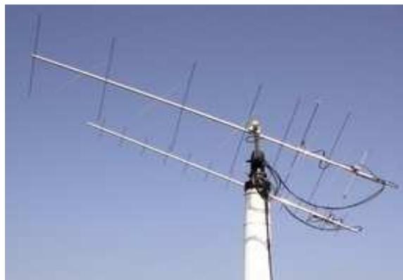
**Gambar 4.3** Antena yagi yang dapat digunakan untuk stasiun penerima APRS
