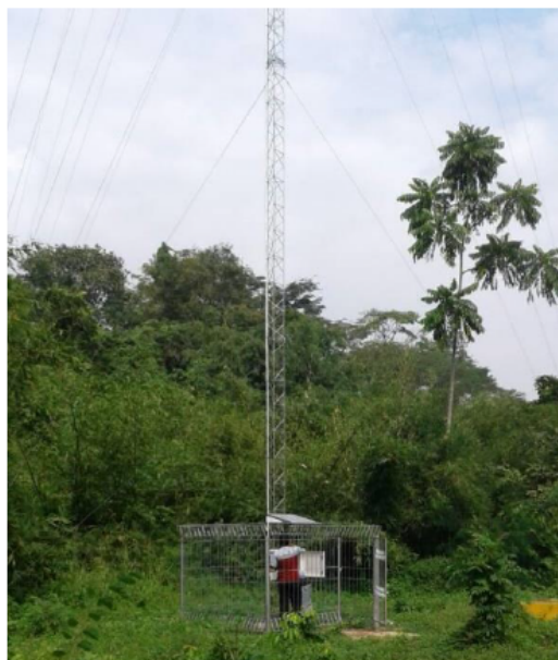
Menara meteorologi RDE.
