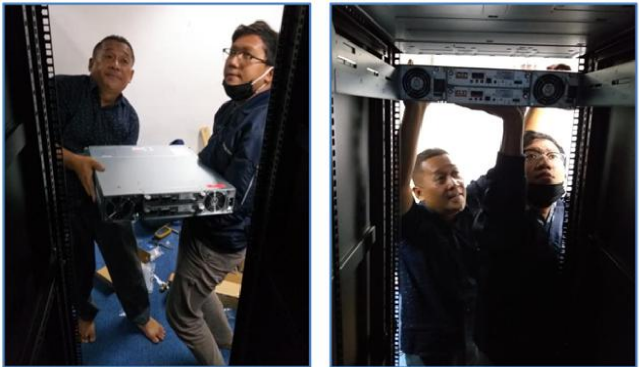
Gambar 6. Dokumentasi Pemasangan Server Web/Storage SPRKK
