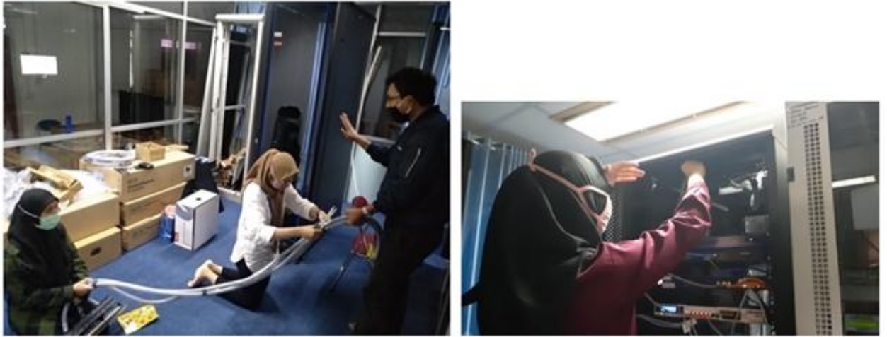
Gambar 3. Proses Instalasi Kabel
