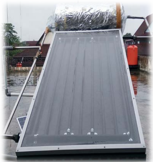
Gambar 2. Pemanas air surya tipe thermosyphone
