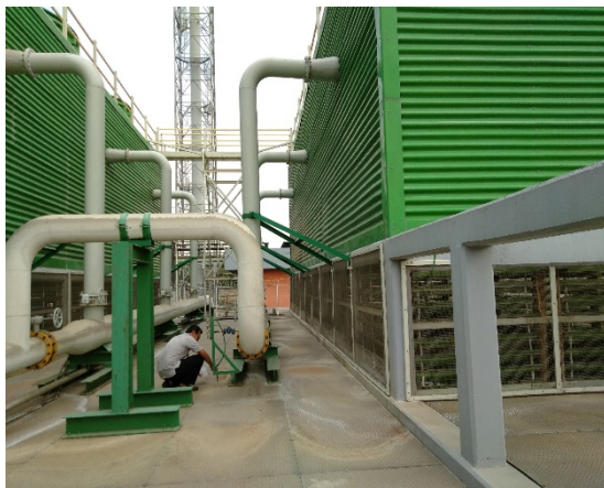
Gambar 2: Pengambilan sampel air pendingin sekunder
