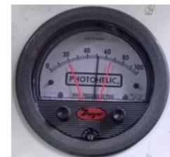
Gambar 5. Kotak *filter* udara buang dan alat ukur beda tekanan
