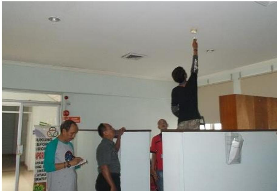
Gambar 3.17 : Uji fungsi fire alarm, heat dan smoke detector
