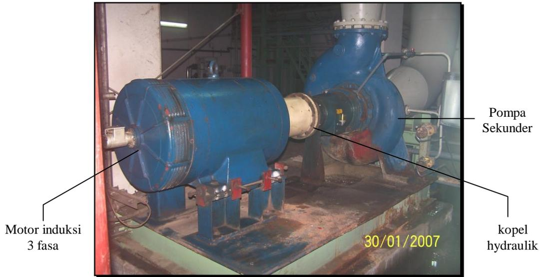
Gambar 2. Rangkaian motor listrik pompa sistem pendingin sekunder
