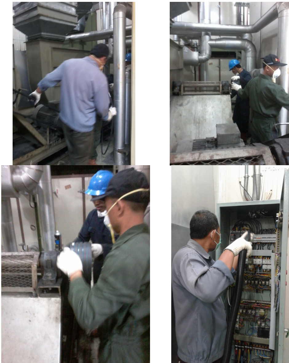
Gambar 2. Kegiatan perbaikan exhaust fan
