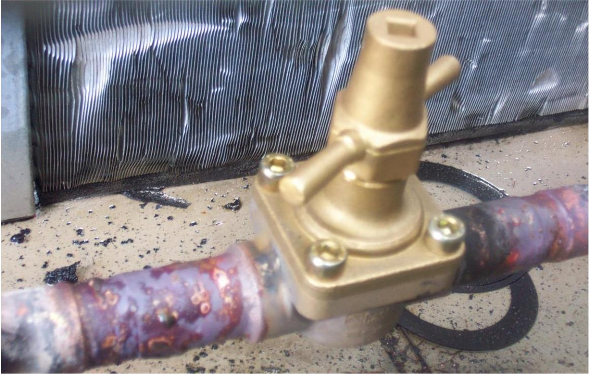
**Gambar 3. Katup Isolasi dan Tabung Filter Dryer Kondisi Terpasang**
