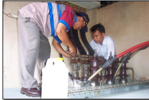
Gambar 6. Pengujian tahanan isolasi kabel (4)
