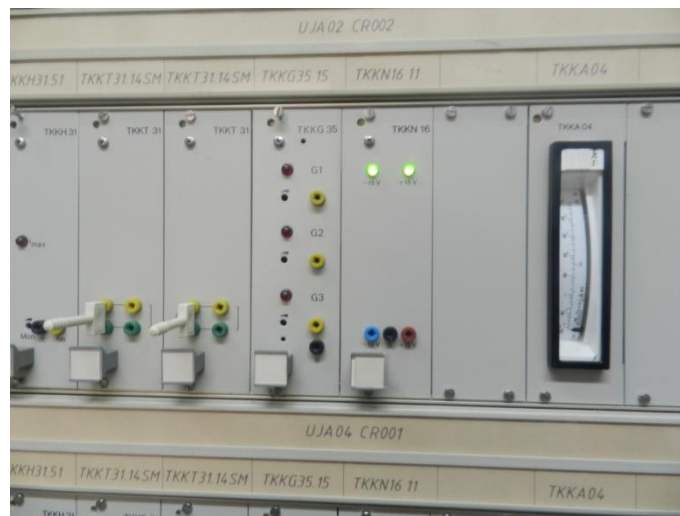
Gambar 2. Perangkat pengolah sinyal sistem UJA
