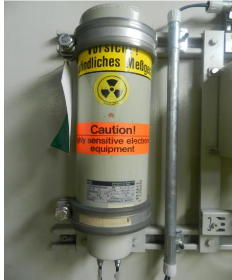
Gambar 1. Detektor sistem pemantau laju dosis gamma UJA
