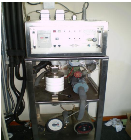
Gambar 1: Sistem pencuplik udara cerobong KLK06 CR004
