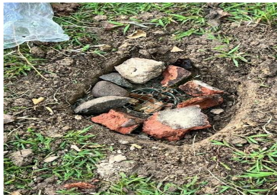
Gambar 6. Pipa yang telah Terpasang
