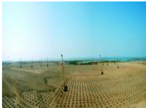
Gambar 4. Gambar kondisi lapangan setelah dilaksanakan DC dan DR.
