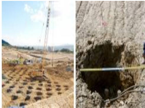
Gambar 3. gambar pembuatan tamping dan bentuk crater (ukurannya sekitar 2 x 2 m)
