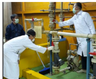
Gambar 2. Pengiriman limbah radioaktif cair dari IRM
