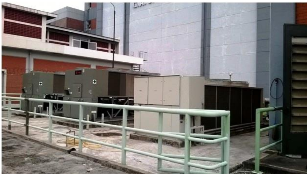
Gambar 1. Sistem Penyedia Air dingin (CWU) QKJ01/02/03
