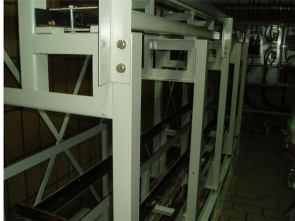
**Gambar 4.** Desain rak untuk batere baru
