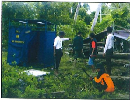
Pemasangan Instalasi WC.
