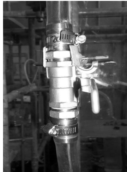
Gambar 4. Penggantian kran dari SS untuk mengurangi kebocoran
