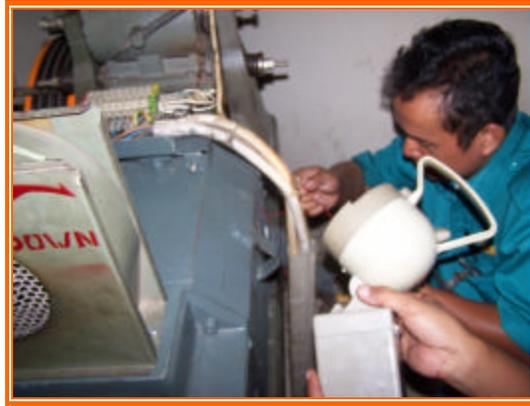
Gambar 8 Pemasangan thermis tambahan pada gulungan motor
