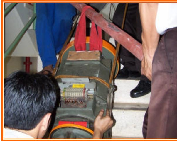
Gambar 4 Motor dikeluarkan dari ruang mesin untuk *rewinding*
