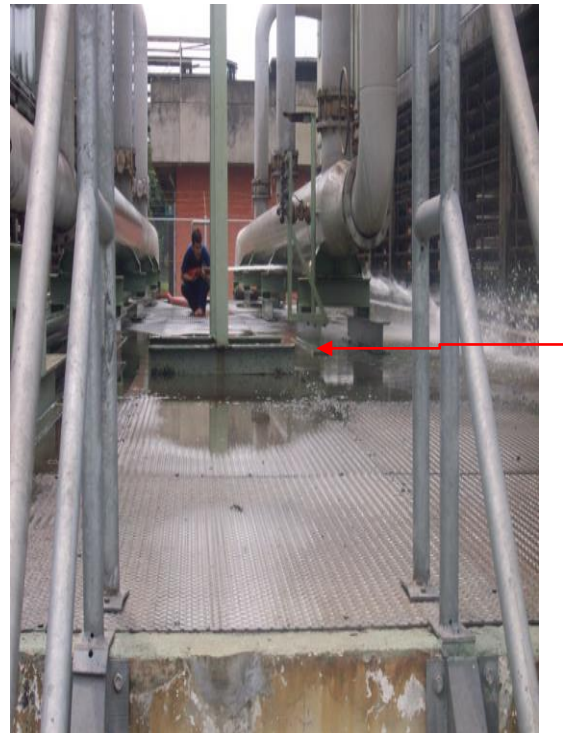
Gambar 4.2: posisi rangkaian rak coupon corrosion pada aliran sistem pendingin sekunder
