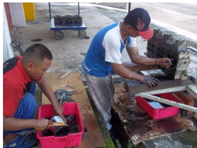
a). Pembersihan bagian-bagian mesin genset
