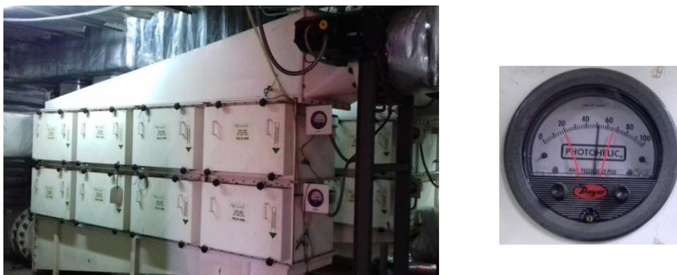
Gambar 2. Kotak *filter* udara buang dan alat ukur beda tekanan
