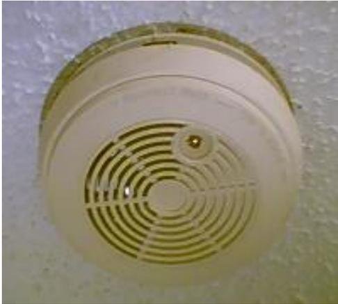
Gambar 2. Sebuah contoh detektor asap menggunakan teknologi nuklir.
