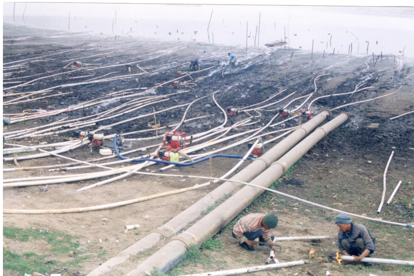
Gambar 6. Penyedotan air dari danau untuk irigasi, menggunakan pompa air dan paralon
