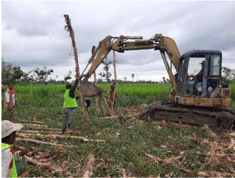
Gambar 4. Pemancangan pondasi kayu gelam
