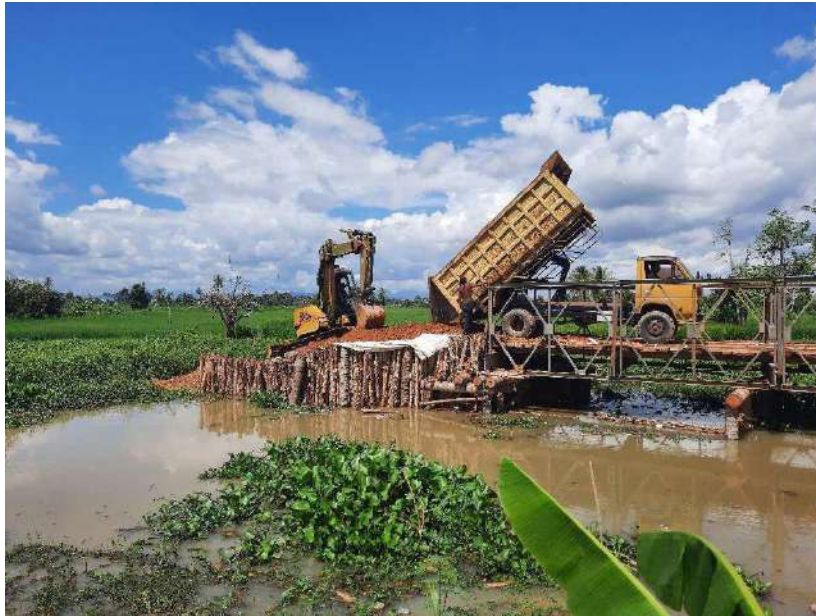
Gambar 5. Dinding kayu gelam pada oprit jembatan
