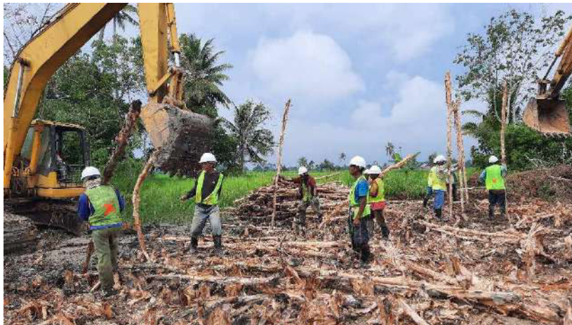
Gambar 4. Kayu gelam dalam pekerjaan jalan
