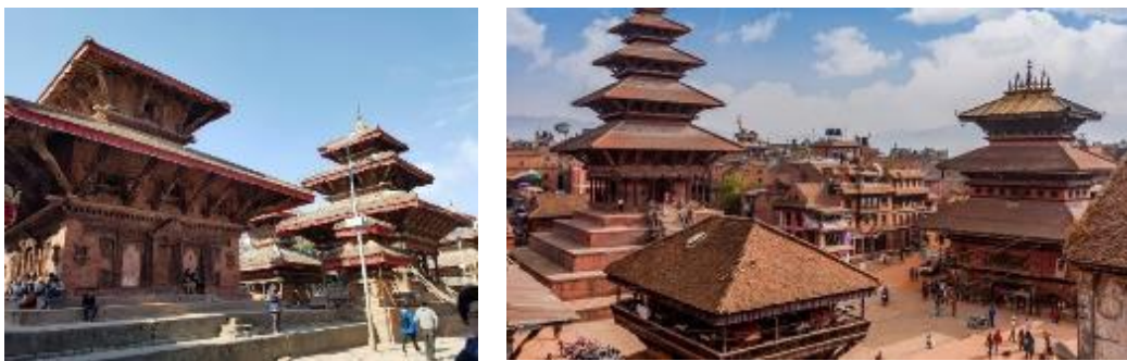
Gambar 28. Bangunan berkonstruksi kayu beratap limasan dengan tambahan kanopi dan tiang penyangga atap yang miring keluar pada Kompleks Istana Kuno di Nepal. (Sumber: www.istockphoto.com )
