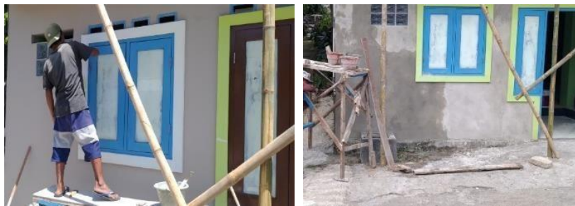
Gambar 10. Pekerjaan pengacian dan pengecatan eksterior
