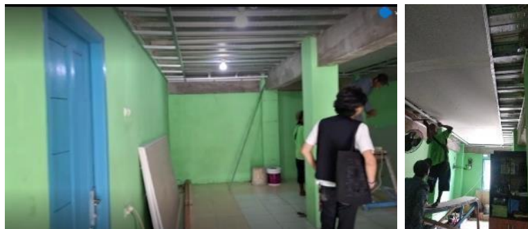
Gambar 7. Proses pekerjaan penutup plafon
