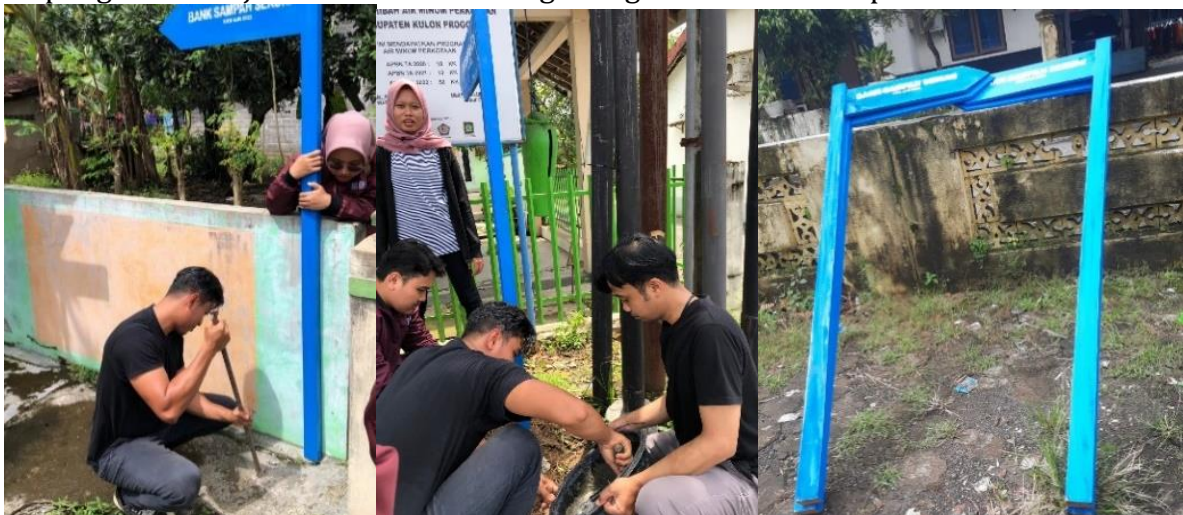
Gambar 13. Pembuatan dan Pemasangan Papan Penunjuk Arah
