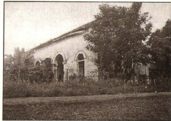
Foto No. 9 Bangunan bekas kantor kepolisian, Mentok
