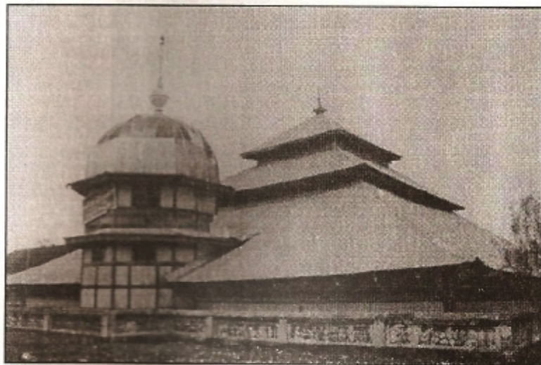
Foto 6 Atap Tumpang Tiga di Masjid Keramat Koto Tuo, Pulau Tengah
