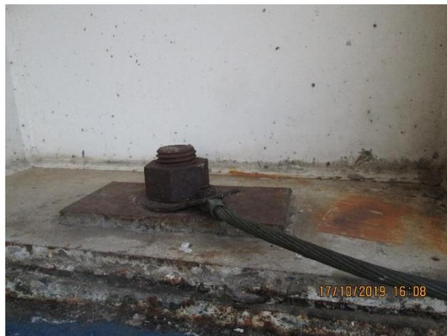
Gambar 7. Korosi pada bagian *bolt and nut*
