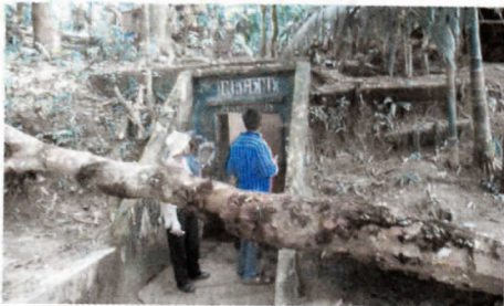
Foto 3 Bunker Perlindungan di Juata Laut (dok. Balar Banjarmasin)
