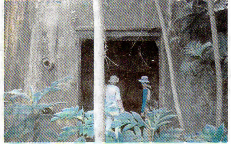
Foto 14. Gardu Listrik di Karungan untuk mendukung pertahanan (dok. Balar Banjarmasin)
