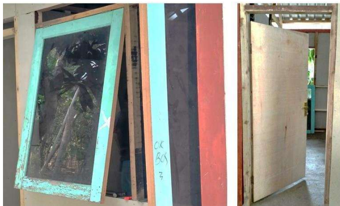
Gambar 8. Proses pemasangan pintu dan jendela
