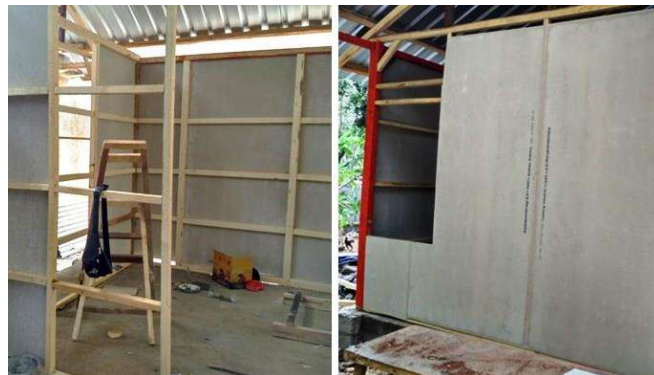
Gambar 6. Pemasangan dinding dari bahan kalsiboard
