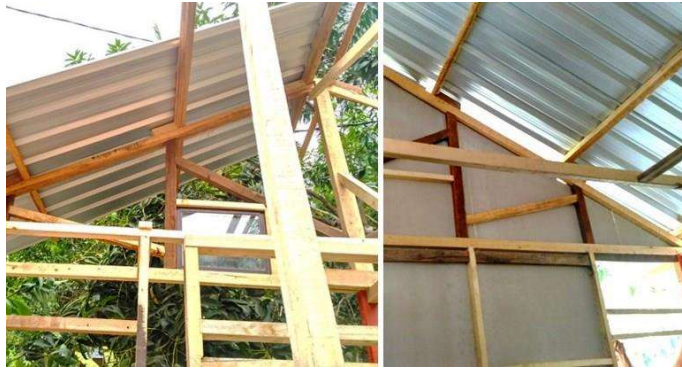
Gambar 7. Proses pemasangan penutup atap dari bahan spandek
