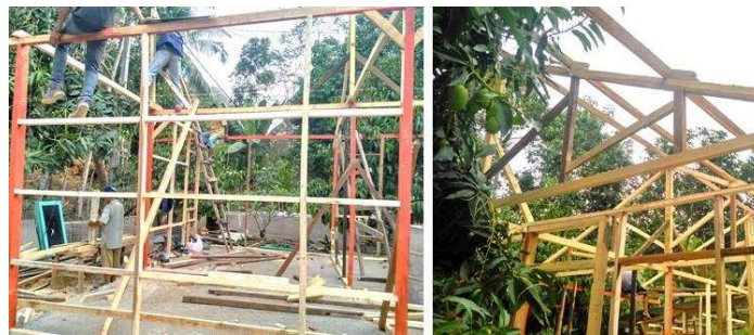
Gambar 5. Proses pembuatan dan pemasangan rangka kayu
