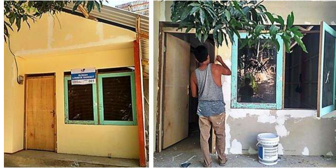
Gambar 9. Proses pengecatan huntara
