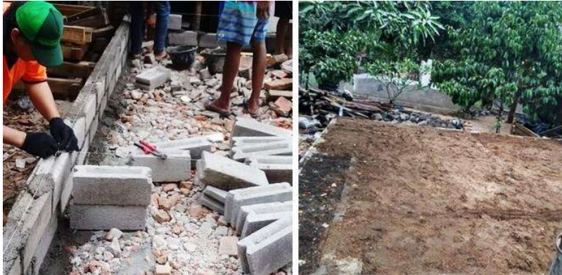
Gambar 3. Proses pembuatan pondasi dan pengurugan tanah
