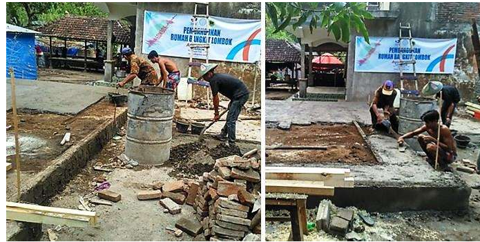
Gambar 4. Proses pembuatan rabat beton sebagai lantai bangunan
