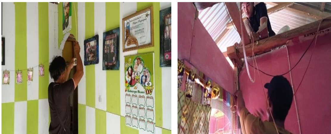
Gambar 5. Foto Dokumentasi Perbaikan Instalasi
